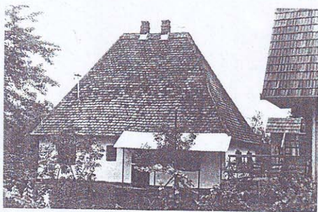
KUĆA POPOVIĆ NEĐE, VUKOSAVCI
